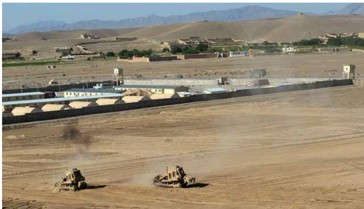
Figura 1. Trabajos de ingenieros en bases
