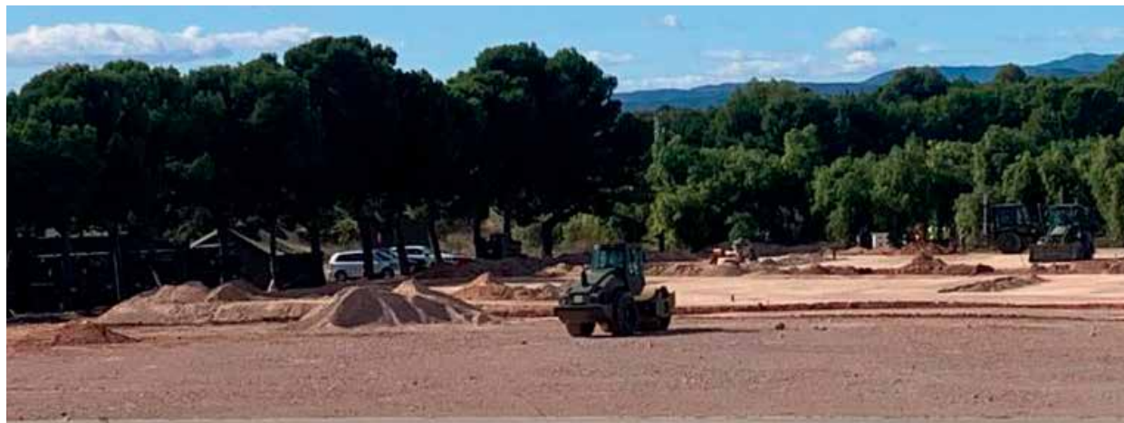
Figura 8. Trabajos plataforma Satélites
