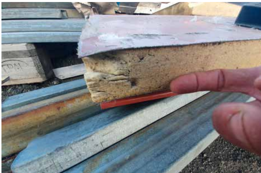
Figura 5. Muestra de panel sándwich que forma el cerramiento del módulo almacén.
