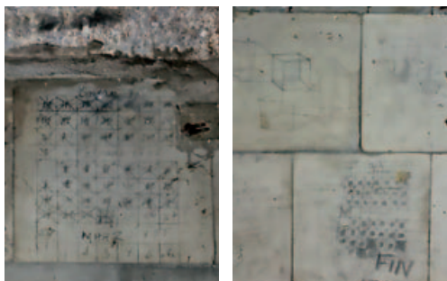
Pintadas encontradas durante las obras. (Fuente: Archivo del Tercio del Norte)
