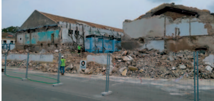
Demolición de las antiguas oficinas y de la nave central del Ramo de Armas. (Foto del autor)
