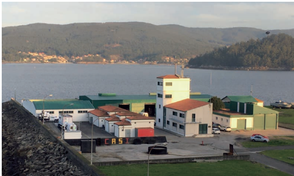
Instalaciones del CEMEDEM en la ENM. (Fotografía del autor)
