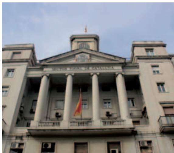
Edificio Sector Naval de Cataluña. (Imagen facilitada por el autor).
