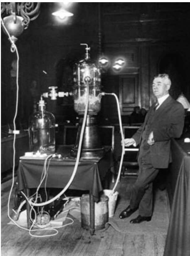
Georges Claude realizando una demostración sobre la conversión de energía térmica oceánica en el Instituto de Francia en 1926.
