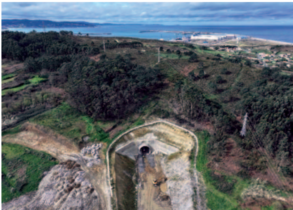
Boca del túnel de acceso ferroviario al puerto exterior de La Coruña. (Fuente: MITMA)
