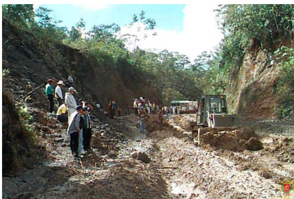
Reparación de viales en Honduras, 1998-1999
