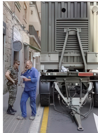
Recuperación del suministro eléctrico. Barcelona, 2007
