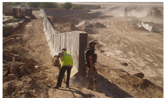
Detalle del montaje del cerramiento perimetral de la base Ruy González de Clavijo en Qala-e-Naw (Afganistán), 2009
