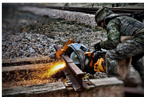
Reparación vías de ferrocarril
