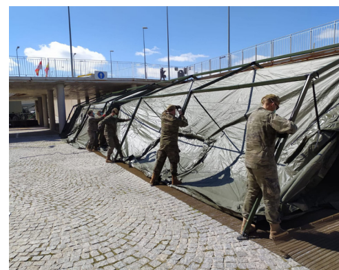
Montaje de instalaciones en apoyo al hospital de Segovia, 2020
