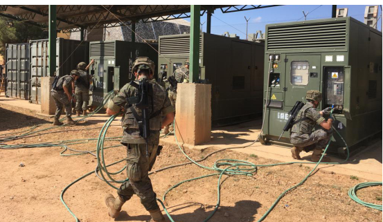
Instalación de energía eléctrica
