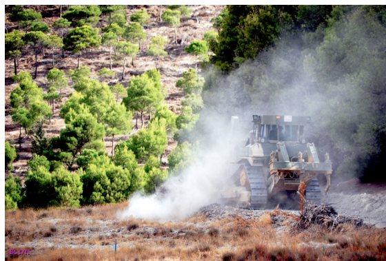
Trabajos de limpieza de cortafuegos
