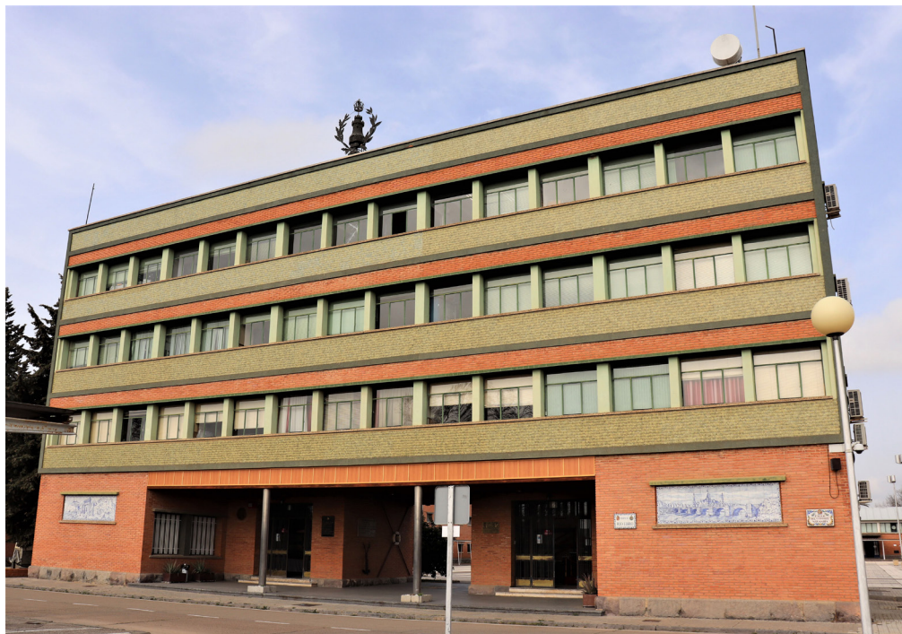
Fachada del edificio de mando del Regimiento de Pontoneros y Especialidades de Ingenieros n.º 12, Monzalbarba (Zaragoza)
