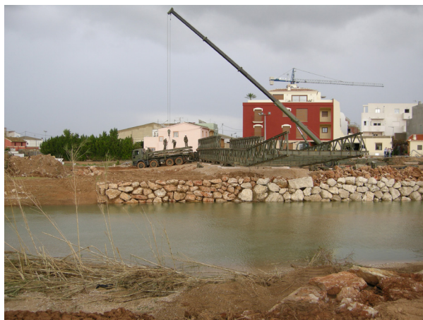
Montaje puente Bailey en Berniabeig (Alicante), 2007
