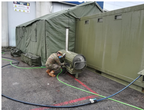
Instalación de climatizador en el hospital IFEMA. Madrid, 2020
