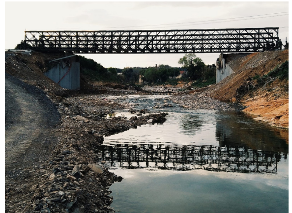
Montaje de puente sobre el río Francolí. Tarragona, 2020
