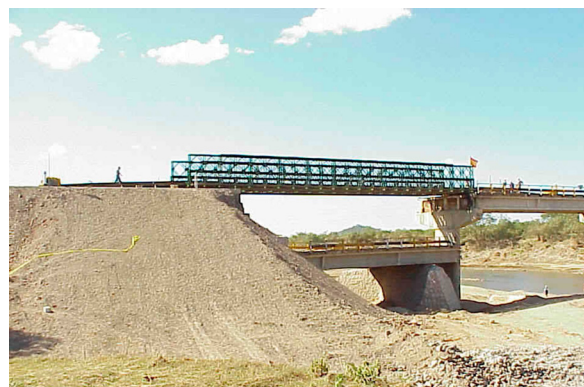
Tendido de puente Bailey sobre el tramo derruido del puente Guasaule, frontera entre Nicaragua y Honduras, 1998-1999
