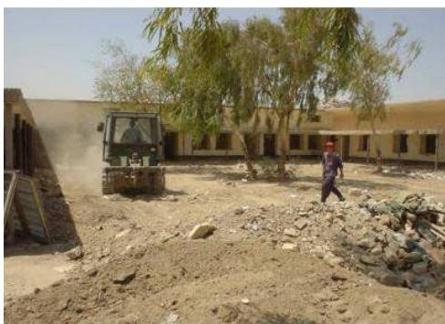
Rehabilitación instalaciones base España. Diwaniya (Iraq), 2003
