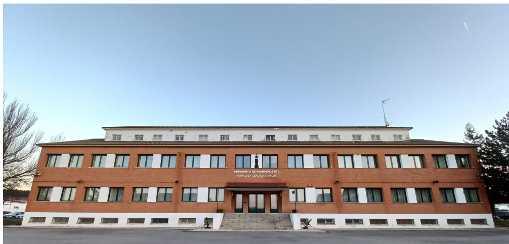
Fachada del edificio de mando del Regimiento de Ingenieros n.º 1, Castrillo del Val (Burgos)
