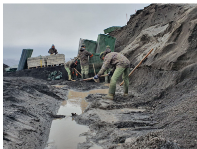
Inicio en la instalación de un muro de contención en la base Gabriel de Castilla (Antártida), 2020
