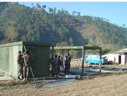
Montaje de contenedores en Arja (Pakistán), 2005
