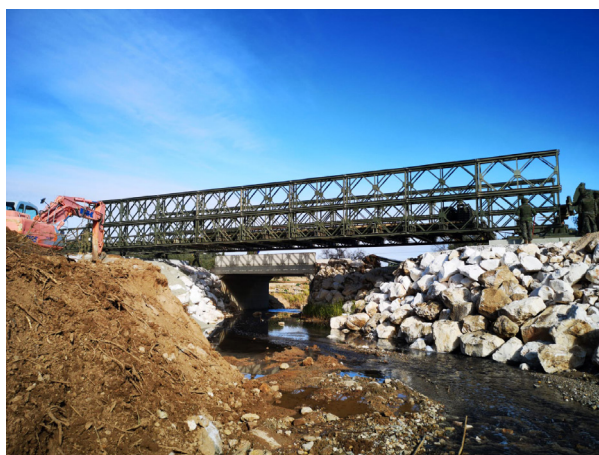
Montaje de puente Bailey en Casariche (Sevilla), 2019
