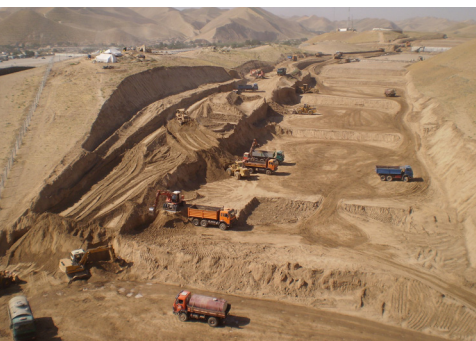
Trabajos de movimientos de tierra de la base Ruy González de Clavijo en Qala-e-Naw (Afganistán), 2009
