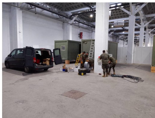
Montaje de las instalaciones de los contenedores de ablución del CREADE en la Fira (Barcelona), 2022
