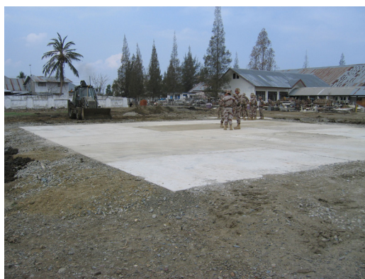
Helisuperficie realizada en Banda Aceh (Indonesia), 2005
