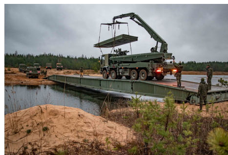
Montaje del puente Dornier (Letonia), 2022
