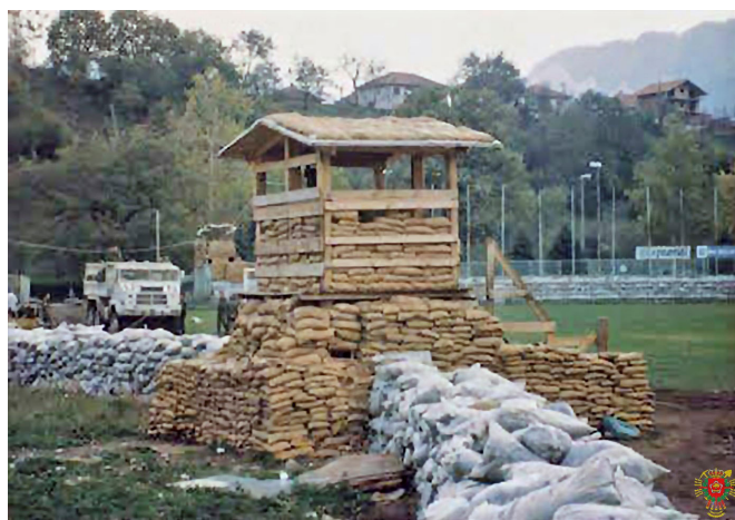
Destacamento de Jablanica, garita de protección de madera
