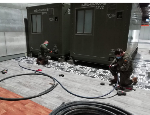
Montaje de contenedores de ablución en IFEMA Madrid, 2020
