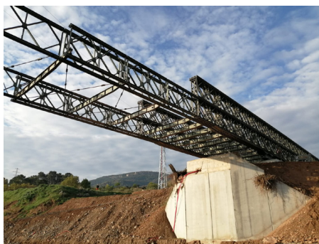
Montaje de puente Bailey en Montblanc (Tarragona), 2020
