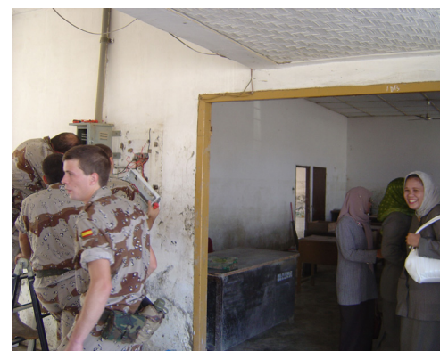
Reparación de la instalación eléctrica de un colegio de Banda Aceh (Indonesia), 2005
