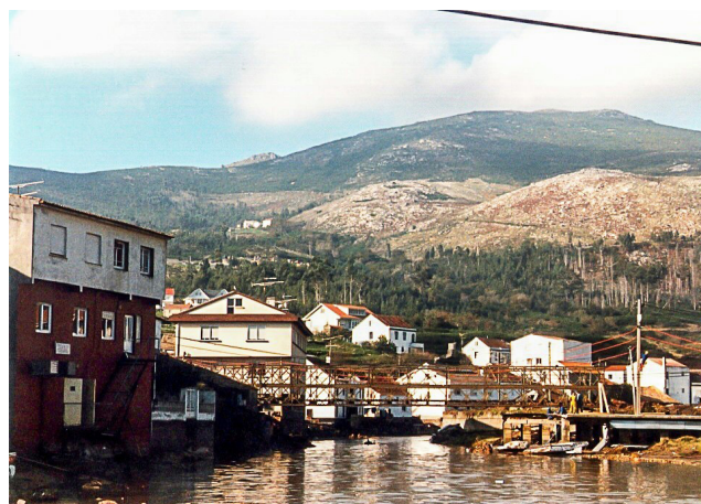
Montaje de puente Bailey en Muros, 1994
