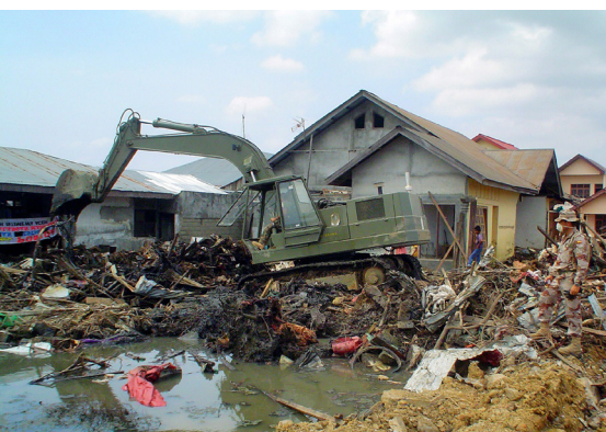
Trabajos de limpieza en Banda Aceh (Indonesia), 2005
