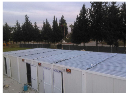
Montaje de contenedores del edificio de la PLMM/BOC en Adana (Turquía), 2015
