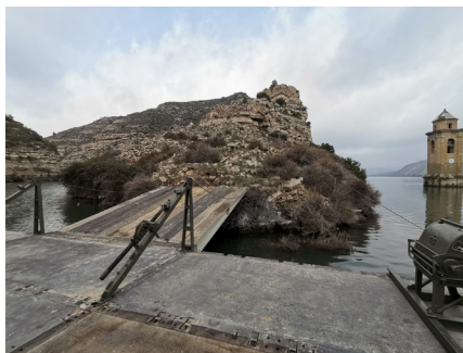
Montaje de compuerta MLC 50 en Fayón (Zaragoza), 2020
