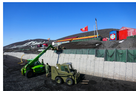
Instalación de un muro de contención en la base Gabriel de Castilla (Antártida), 2020
