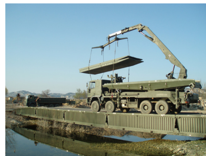
Paso de cortaduras. Puente Dornier
