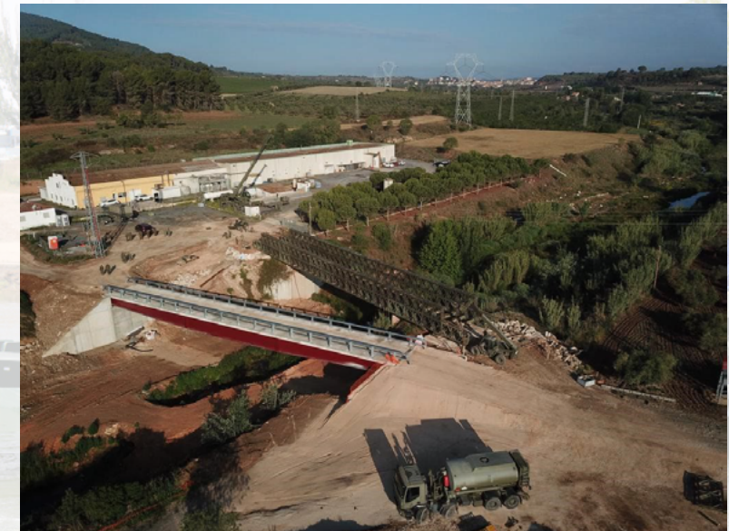
(Fotografía 11. Desmontaje del puente de Montblanc)
