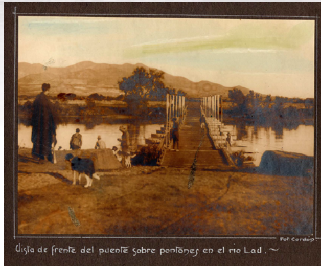
(Fotografía 6. Vista del puente sobre el río Lau)
