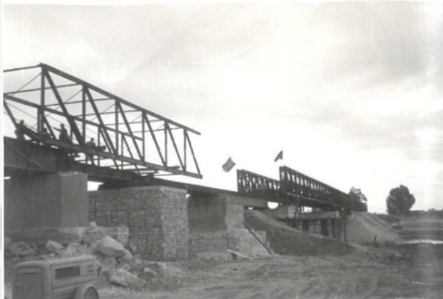
(Fotografía 8. Puente de FF.CC. ayuda a Túnez)
