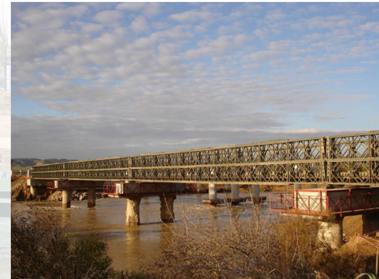
PUENTE BAILEY INSTALADO EN VILAFRANCA. 2004
