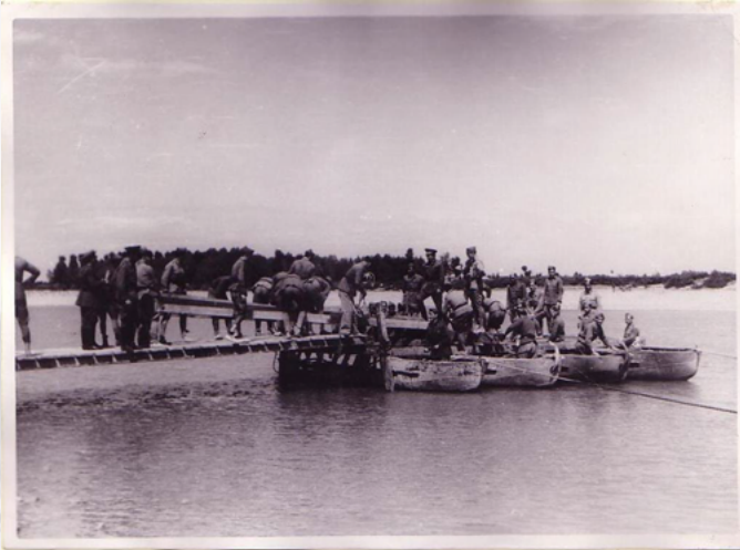
(Fotografía 3. Prácticas de puentes 10 Tm durante Escuelas Prácticas 1951)
