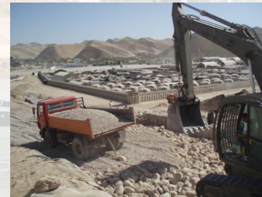
(Fotografía 9. Construcción PSB en QeN - Afganistán)
