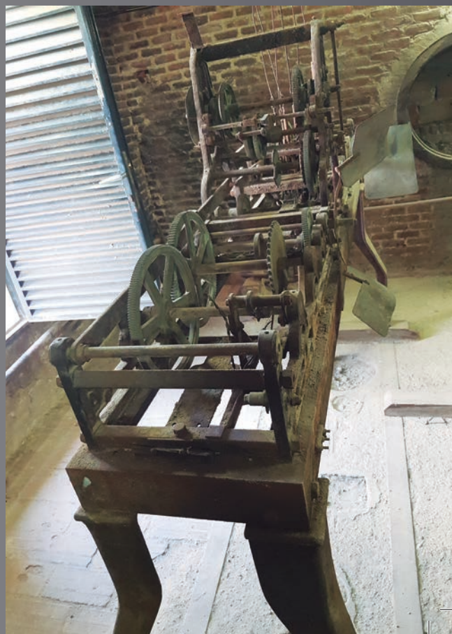
▼ Estado actual de los mecanismos del reloj
