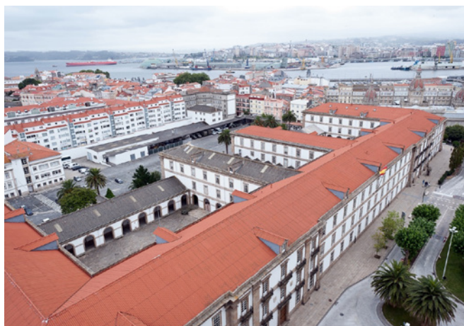
Acuartelamiento de Atocha en La Coruña
