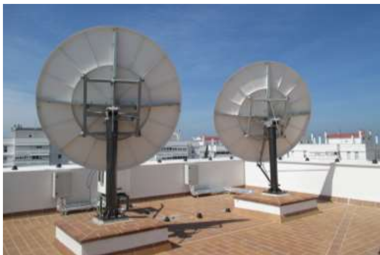
Figura 4.7: Antenas de la estación 1 (izqda.) y estación 2 (dcha.) del sistema TWSTFT, en la azotea del laboratorio.
