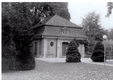
54- Sede Villa Boveri / Hauptsitz Villa Boveri
