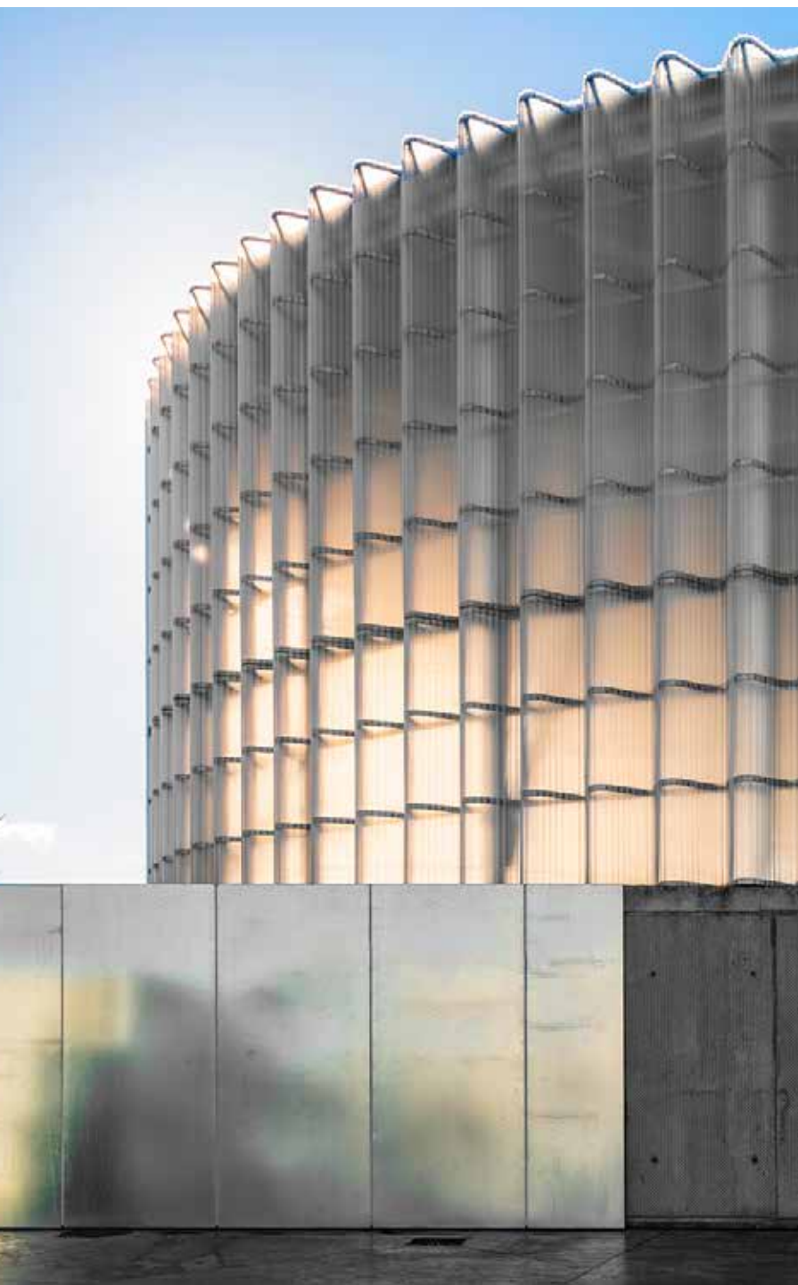
Central térmica DH Ecoenergías en Palencia [FRPO] Fernando Rodríguez, Pablo Oriol España
