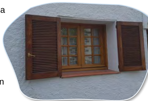
Ilustración 11. Instalación de nuevas ventanas.
