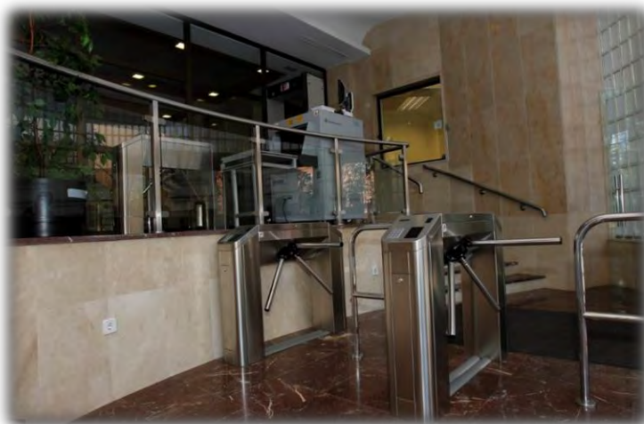
Ilustración 19. Tornos para el control de acceso del personal del INVIED O.A.
