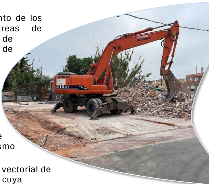
Ilustración 10. Excavadora durante una demolición.
