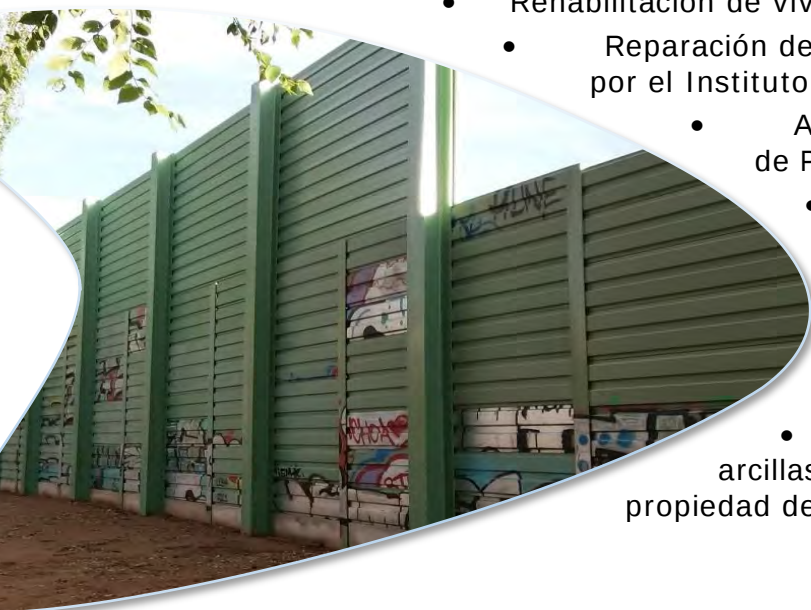
Ilustración 12. Montaje de pantallas acústicas.
